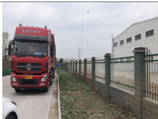
场外道路区土地整治
