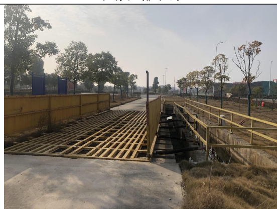
堆场区洗车池
