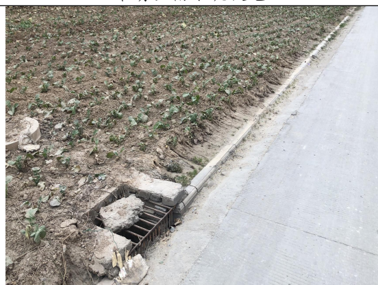
场外道路区雨水排水管（雨水口）
